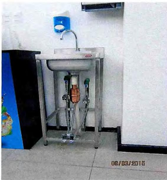
Fotografía N° 3 – 03/09/2015: Lavadero ubicado en "Línea de distribución" con cañerías de agua potable de material polipropileno a la vista, casino sede Macul.
