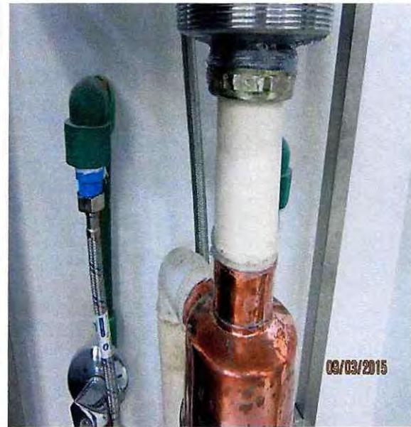
Fotografía N° 4 – 03/09/2015: Lavadero ubicado en "Línea de distribución" con cañerías de agua potable de material polipropileno a la vista, casino sede Macul.
