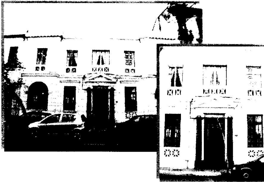
Fachada del Decanato de la Facultad de Humanidades y Tecnologías de la Comunicación Social donde funcionan los proyectos IPGH y OEA
